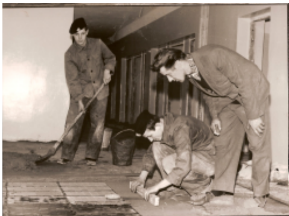
Wykończenia wewnątrz wodzisławskiego szpitala
